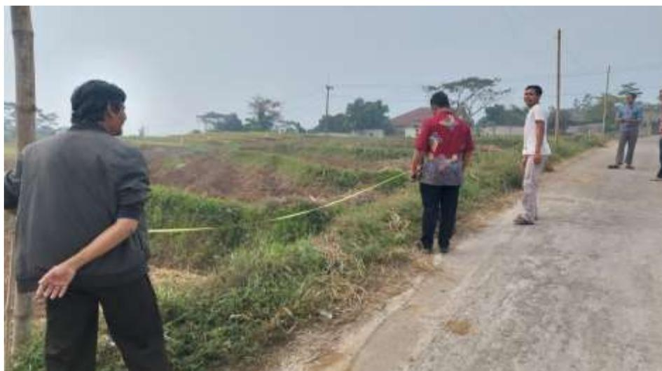
**Gambar 5.** Pengukuran kebutuhan kabel PJU
