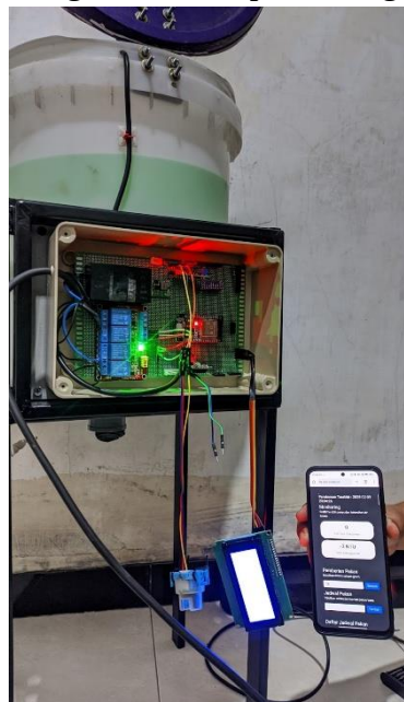
Gambar 6. Instalasi dan uji komunikasi IoT.
